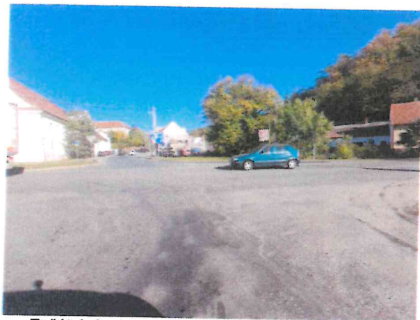
Začátek úseku, ztráta makrotextury
