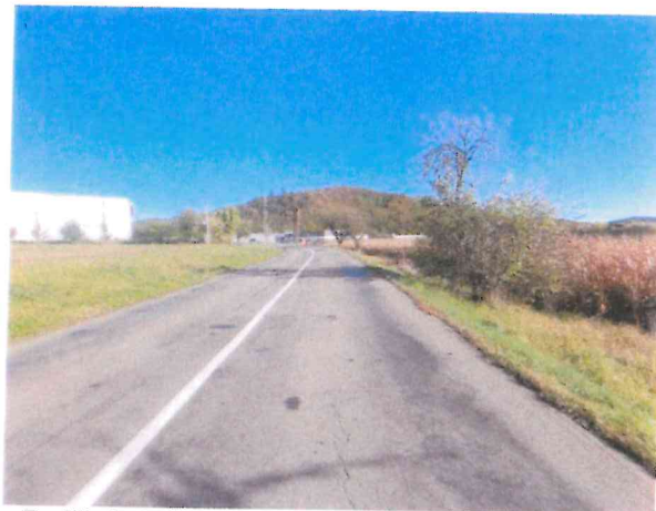
Podélná trhлина, ztráta makrotextury, vysprávk
