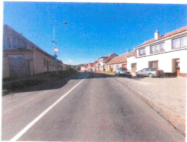
Příčná trhlina, ztráta makrotextury
