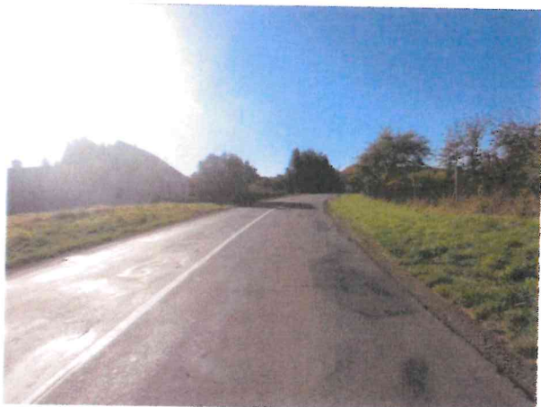
Příčné trhliny, vysprávkvy
