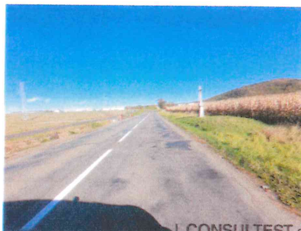
Podélná trhлина, ztráta makrotextury
