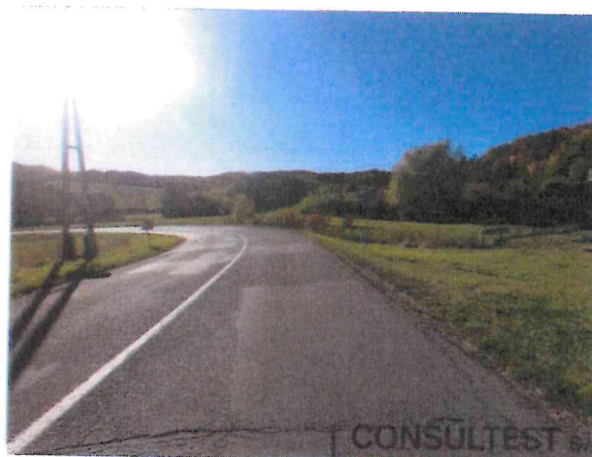
Konec úseku, trhlina rozvětvená příčně
