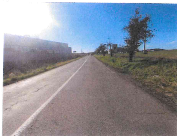
Podélné trhliny, příčné trhliny
