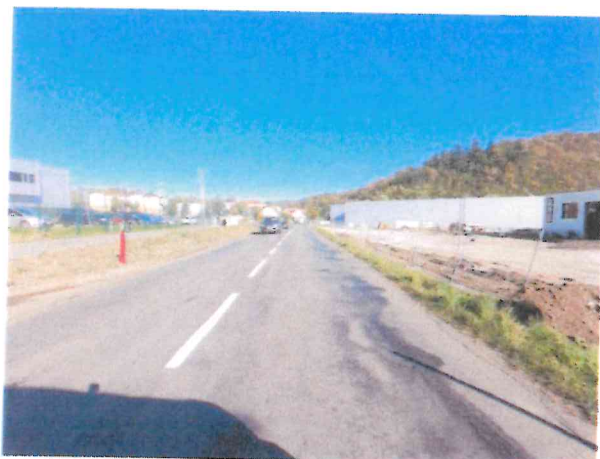
Olamování okrajů vozovky, ztráta makrotextury
